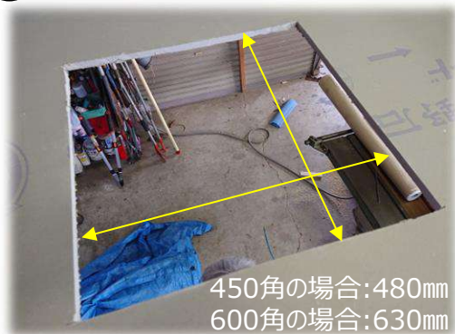
① 天井材に開口をあける
