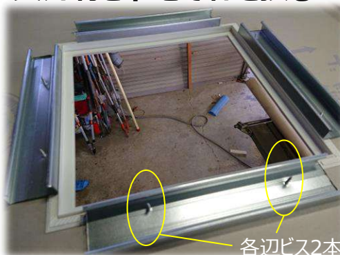
天井材と下地で枠を挟む
