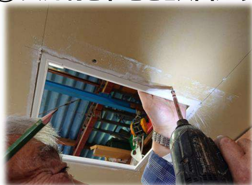
④ 天井材と下地をビス固定する
