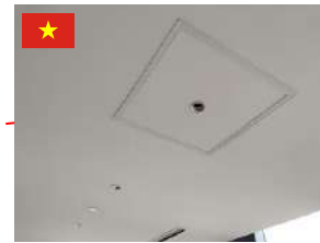
天井点検口枠
