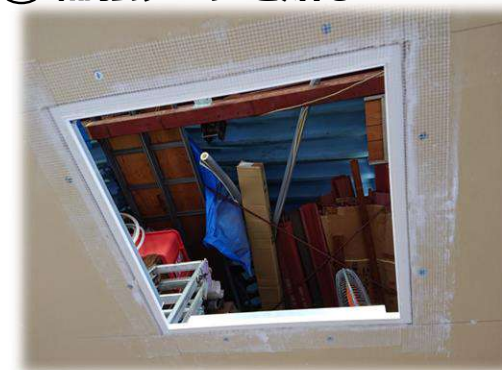
⑤ 補強テープを貼る
