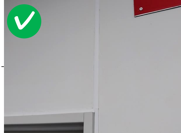
<Tường với JOINER> Ngăn chặn vết nứt
